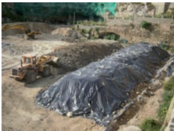
Acopio de suelos en biopilas.
